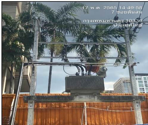
รูปที่ 2-38 หม้อแปลงไฟฟ้าและแผงควบคุมวงจรไฟฟ้า พร้อมทั้งติดตั้งเต็อนอันตราย
