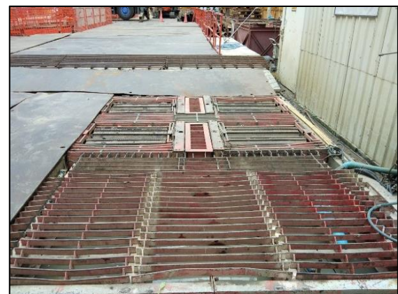
รูปที่ 2-14 กิจกรรมทำความสะอาดล้อรถบรรทุก และพื้นที่ล้างล้อรถบรรทุก
