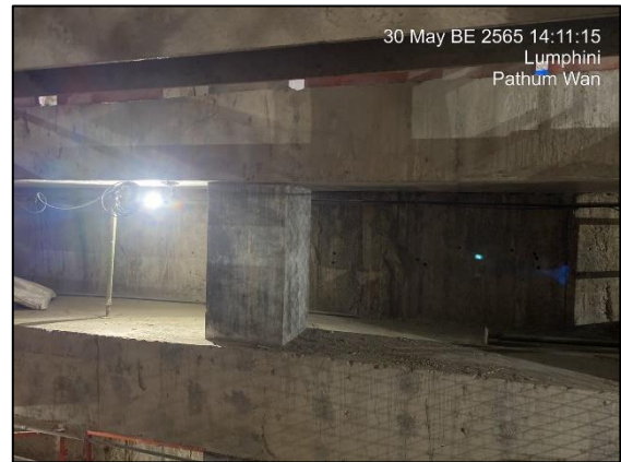
รูปที่ 2-17 ผนังรับแรงกันดิน (D-Wall)
